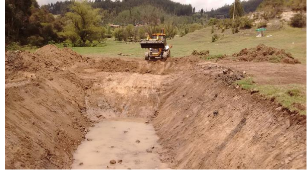
Şəkil 7. Su hovuzunun qazılması
