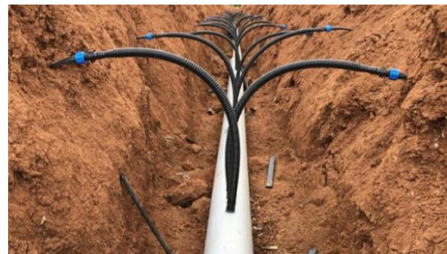
Şəkil 9. Damlama çıxışlarının birləşməsi
