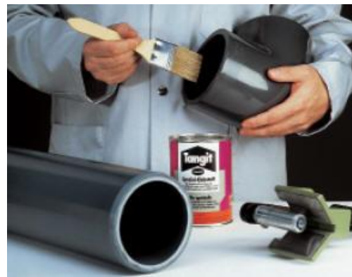
Şəkil 5. PVC boru yapışqanla birləşmə
