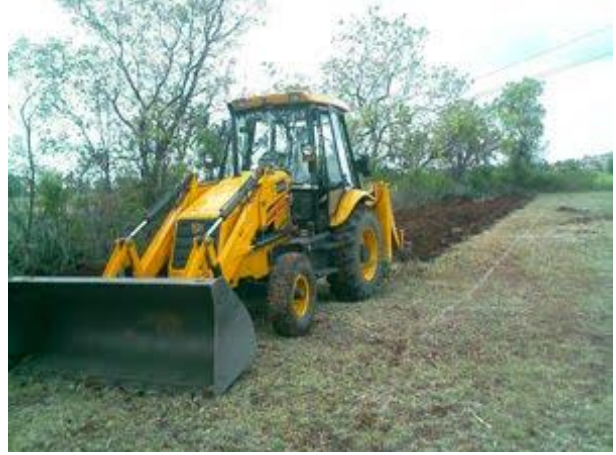
Şəkil 1. Boru yerinin işarələnməsi və qazılması
