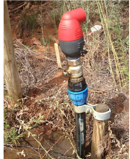
Şəkil 5. Altında ventil quraşdırılmış hava klapanı
