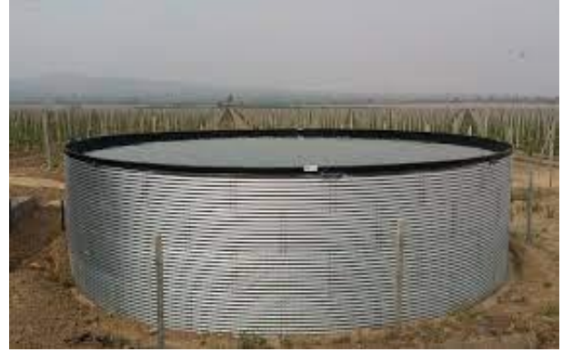
Şəkil 8. Dəmir və geo-membran əsaslı su rezervuarı
