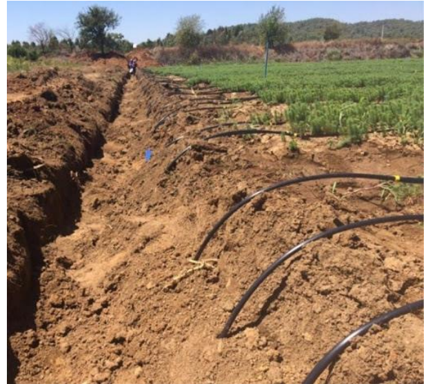
Şəkil 1. Damlama borularının sektor borusundan çıxış forması
