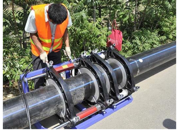
Şəkil 1. PE boruların alın qaynağı
