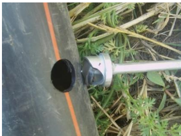
Şəkil 7. Boruda dəliyin açılması
