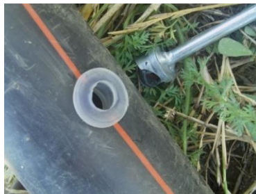
Şəkil 8. Dəliyə contanın keçirilməsi
