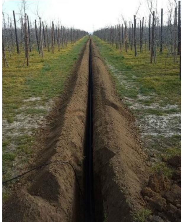
Şəkil 2. Boru yerinin işarələnməsi və qazılması
