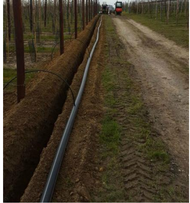
Şəkil 3. Sektor xətlərinin qazılması
