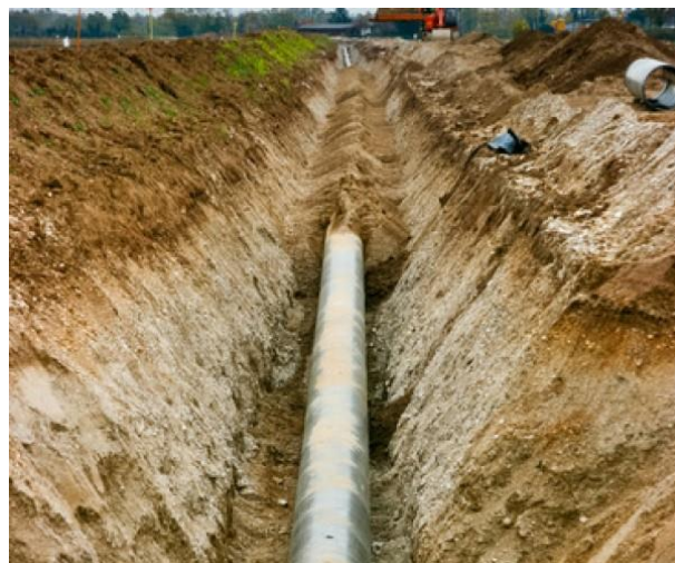
Şəkil 1. Qazıntı və əks dolma işləri
